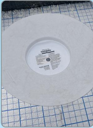
Das auf die Isolation aufgesetzte Aufstockelemente entwässert den Dachbelag.
