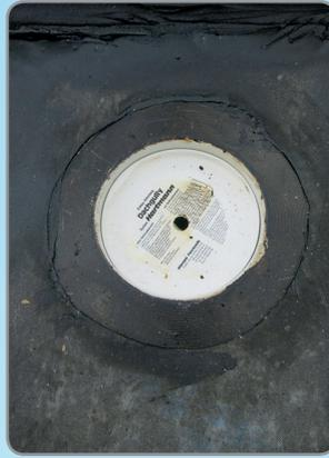
Die Dachhaut wird an den Gully angeschlossen. Der breite, gerillte Klebeflansch sichert die absolut dichte Verbindung.
