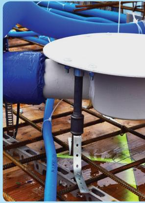
Sofort beginnt die Montage auf dem Dach. Der Gully wird an dem gewünschten Ort fixiert und angeschlossen.
